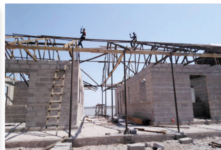
Timmeren aan de dakconstructie.
