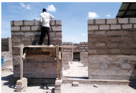
Metselwerken van de tweede ziekenboeg.
