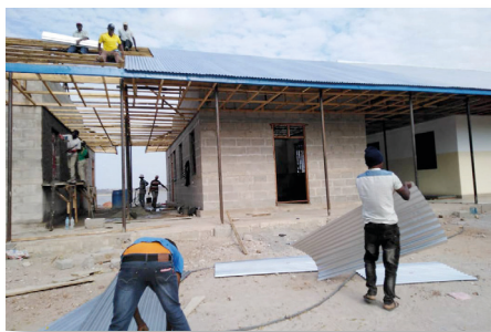
Dak dichtleggen met golfplaten.
