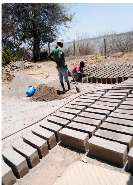
Ter plaatse maken van de cementblokken.
