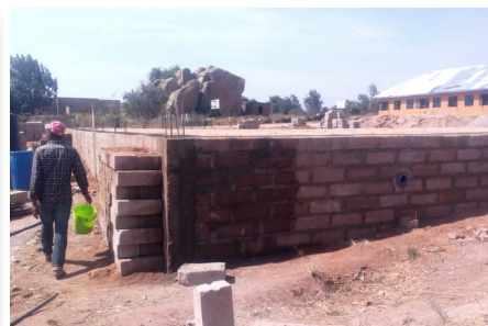
Funderingsmuren en vloer klaar.
