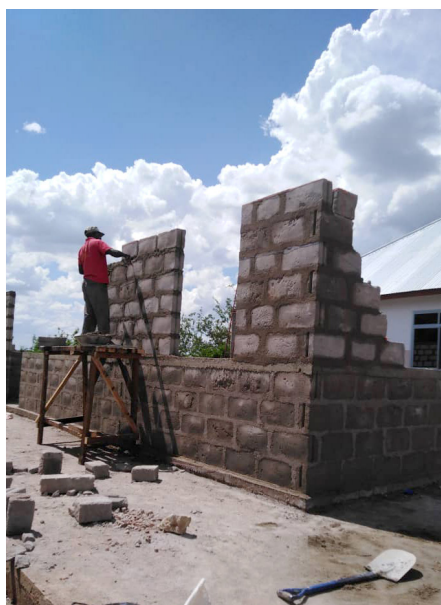
Metselwerken tussen de ramen.
