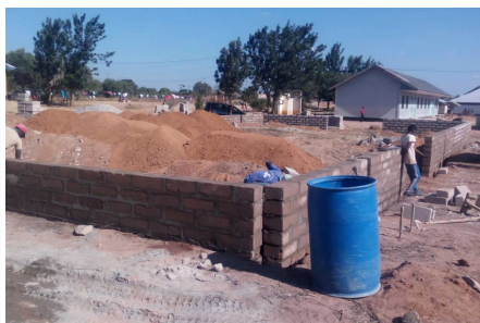
Hoge funderingsmuren wegens hellend terrein.
