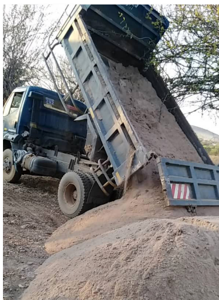
Aanvoeren van de bouwmaterialen.
