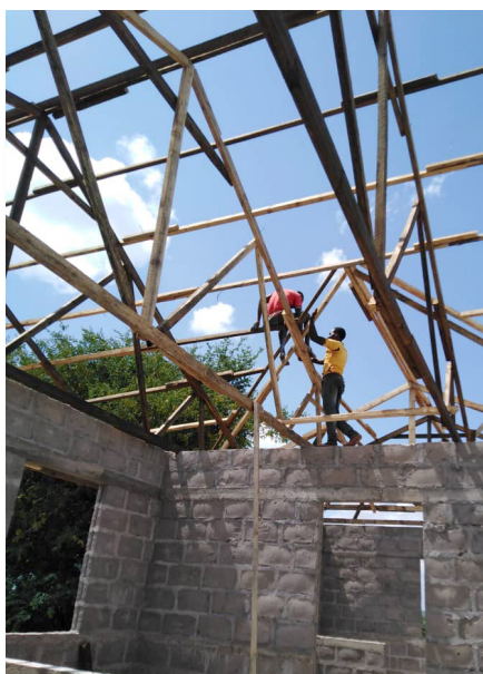
Timmerwerken voor het dak.
