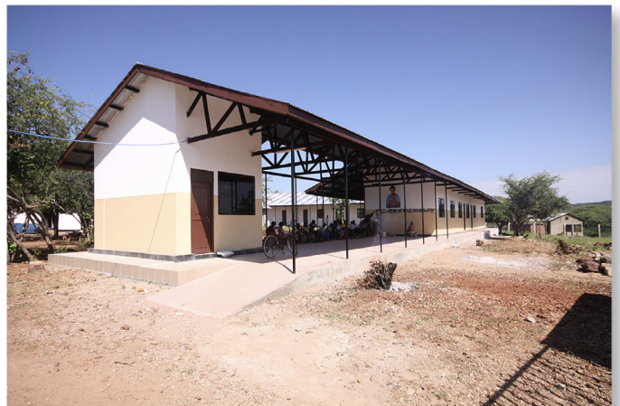
In 2011 werd een nieuwe materniteit en daghospitaal gebouwd aan het bestaande ziekenhuis van Mwanzugi. In 2018 volgde een labo en in 2019 een operatiekwartier met twee operatiezalen.
