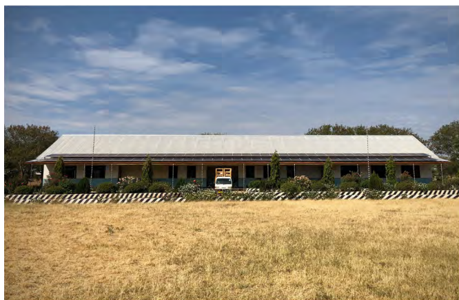
In totaal 80 zonnepanelen op het dak van het administratieve gebouw.
