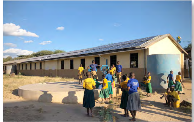
Zestig zonnepanelen op het dak van de klassen in de lagere school.
