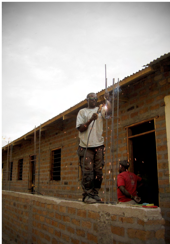
Metsel- & laswerken aan de nieuwe klassen op de lagere school.
