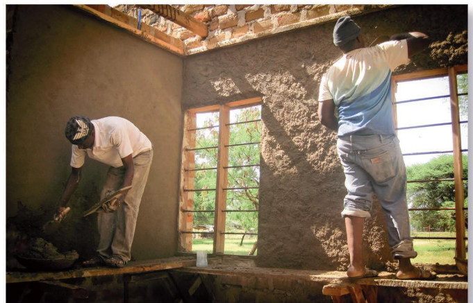
Onze bouwploeg pleistert de binnenmuren.
