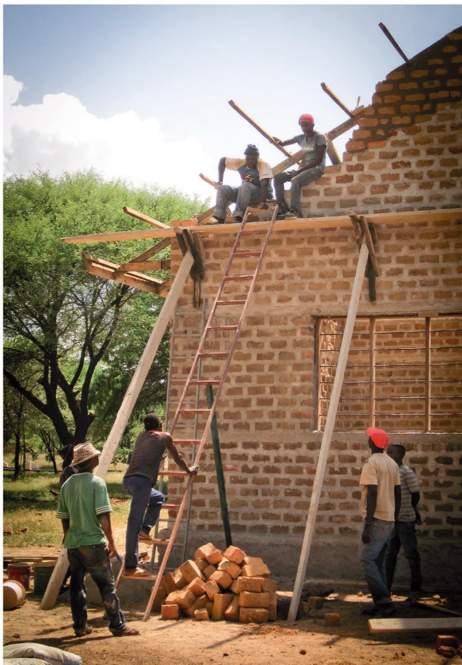
Opmetzen van de topgevels van de administration block.
