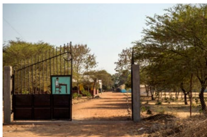
De nieuwe toegangspoort en omheining rondom het terrein van onze secundaire meisjesschool.
