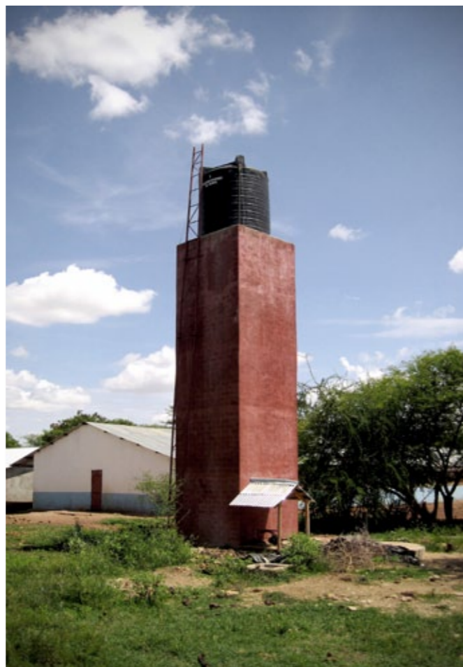
Watertoren van 9m hoog om de labo's van water te voorzien.
