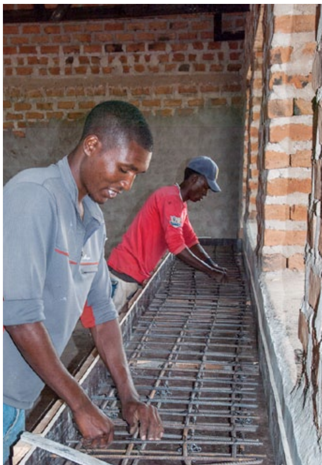
Aanbrengen van de wapening voor de betonnen werkbladen.
