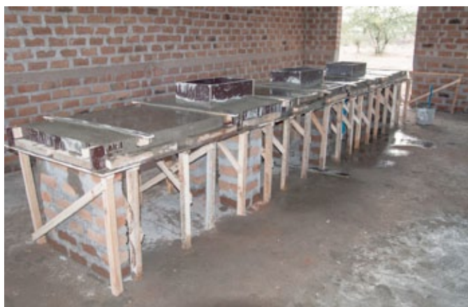
Bekisten van de betonnen werkbladen.
