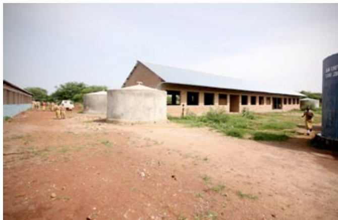
Het laatste bouwwerk van pater Bolle: de ruwbouw van drie schoollaboratoria voor chemie, biologie en fysica.
