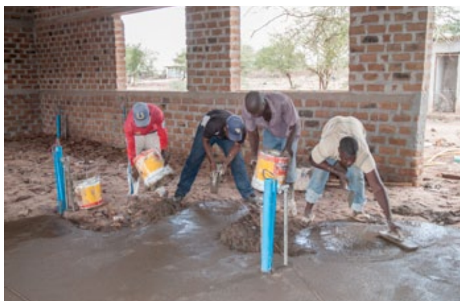
Plaatsen van de ondervloer in het chemielabo.
