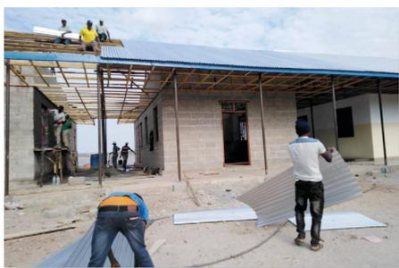
*Fermeture du toit avec des plaques ondulée.*
