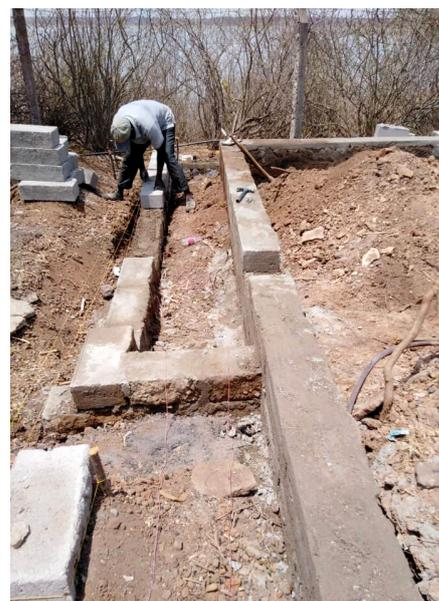
*Travaux de maçonnerie des fondations..*
