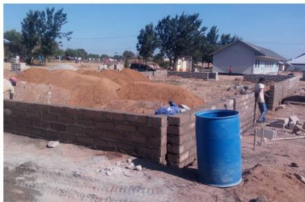
*De hauts murs de fondation à cause de terrain en pente.*
