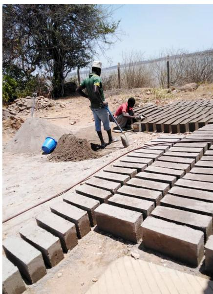
*Fabrication sur place des blocs de ciment.*
