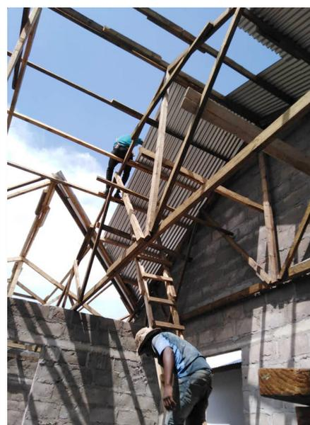
*Placement de tôles ondulées sur la toiture.*
