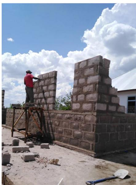
*Travaux de maçonnerie entre les vitres.*
