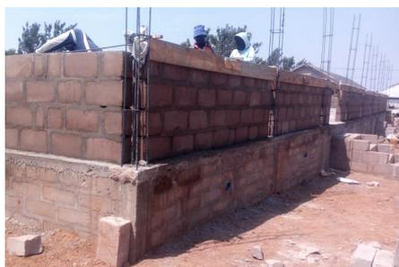
*Maçonnerie et coffrage pour poutre circulaire.*
