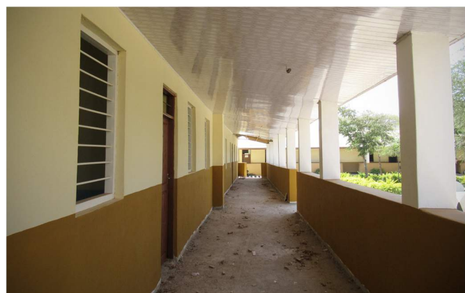
Accès à la salle de réunion et aux locaux de direction.
