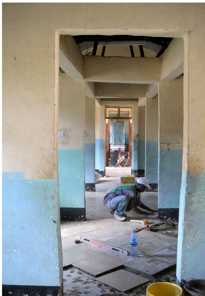
Travaux de carrelage dans les dortoirs de l'internat.
