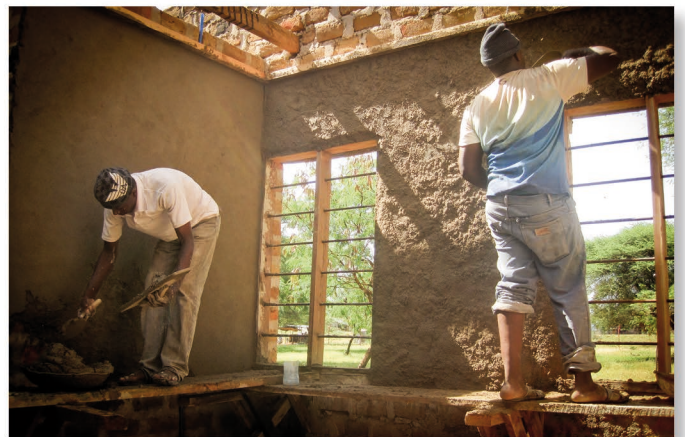
Notre équipe de construction plâtre les murs intérieurs.
