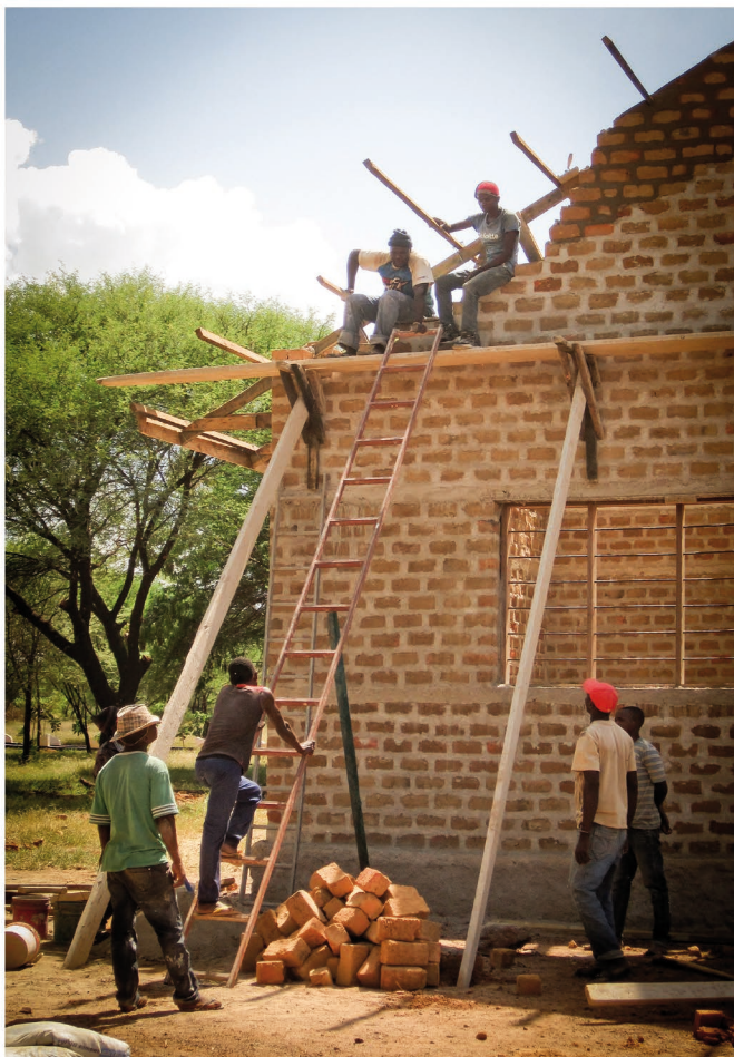
La maçonnerie des frontons du bloc d'administration.
