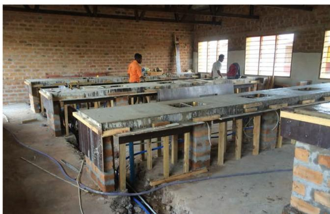
Des plans de travail en béton coulés sur place.
