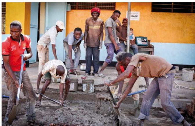
L'équipe de construction prépare le béton pour le sol du labo.
