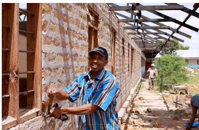
Nico, notre entrepreneur pour les travaux de construction à l'école.
